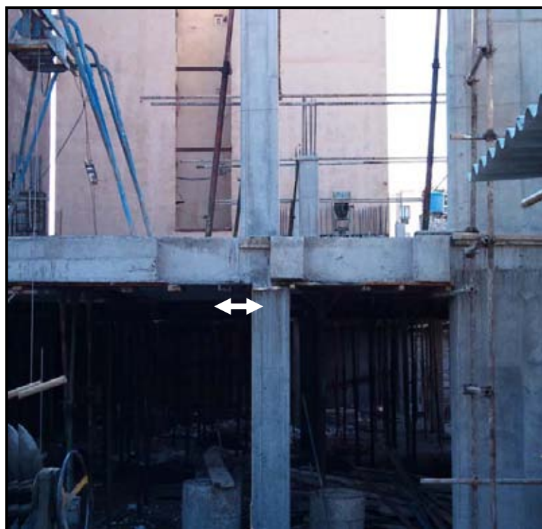
(انحراف ستون از موقعیت مشخص شده در پلان 12 \leq \Delta \leq 25\text{mm} )
