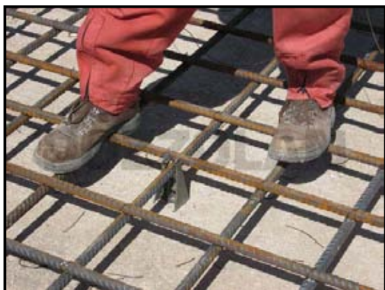
(رعایت پوشش مناسب آرماتورهای فونداسیون با استفاده از اسپیسر)
