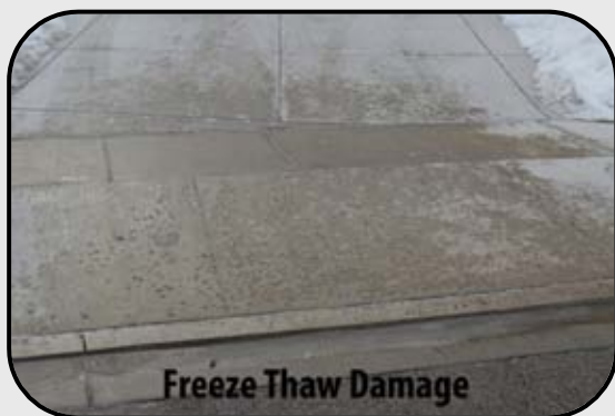
(ترک خوردگی و فروپاشی سطح بتن بر اثر دوره‌های یخ زدن و آب شدن)
