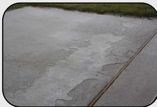
(ترک خوردگی و فروپاشی سطح بتن بر اثر دوره‌های یخ زدن و آب شدن)
