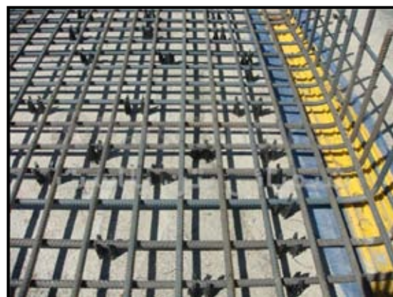
(رعایت پوشش مناسب آرماتورهای فونداسیون با استفاده از اسپیسر)
